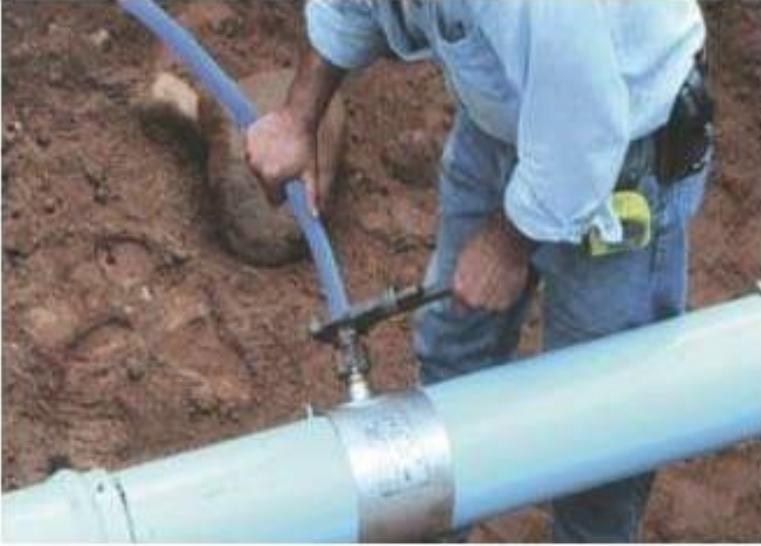
Placez la conduit MUNICIPEX à un angle de 10-20 degrés au-dessus de la ligne horizontale au niveau du raccord avec la conduite principale.
