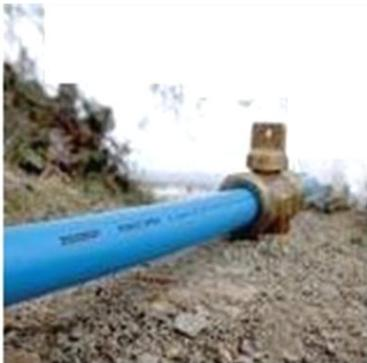
**REMARQUE :** tout contact avec des roches pointues, débris de construction ou matériel gelé doit être évité pour ne pas endommager les conduites enfouies.
