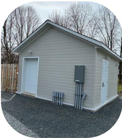
Travaux du réseau d'eau potable du secteur Guay, en voie d'être finalisés.
