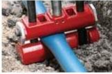
Obturation de la conduite
